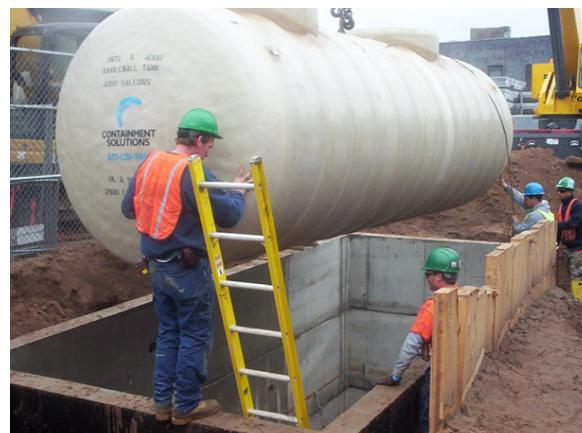
Trabajadores instalando tuberías y tanques de almacenamiento de producto, que forman parte de los 10 nuevos pozos de recuperación con bombas duales de la planta del Proyecto de Recuperación Ambiental de Greenpoint de ExxonMobil. Se prevé que todos los pozos estén completamente en operación al finalizar el año.
