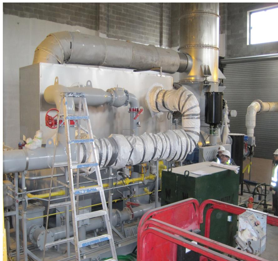
Ingenieros y contratistas instalaron y finalizaron algunas de las conexiones en la unidad de oxidación Flame, el principal tratamiento para el sistema de extracción de vapor del suelo.
