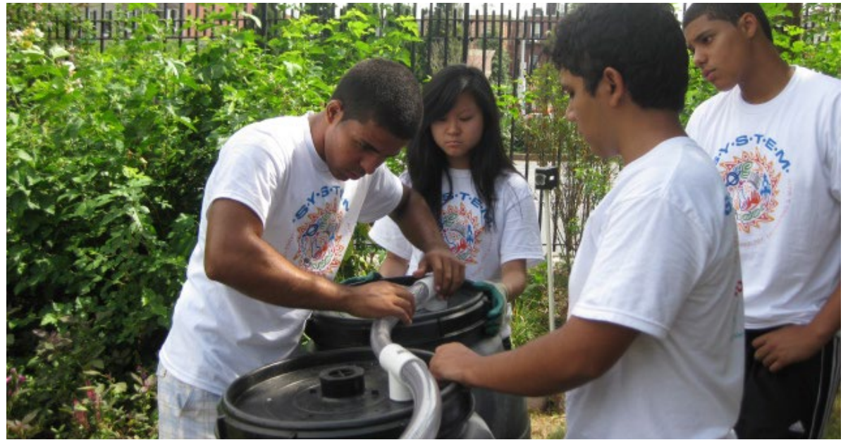
Los estudiantes de SYSTEM construyen un sistema para almacenamiento de aguas lluvias en barriles, en el parque Lentol Garden. (De izquierda a derecha): Kevin Negron, Erica Lei, Rai Munoz y Donatello Meltz DeMeo.
